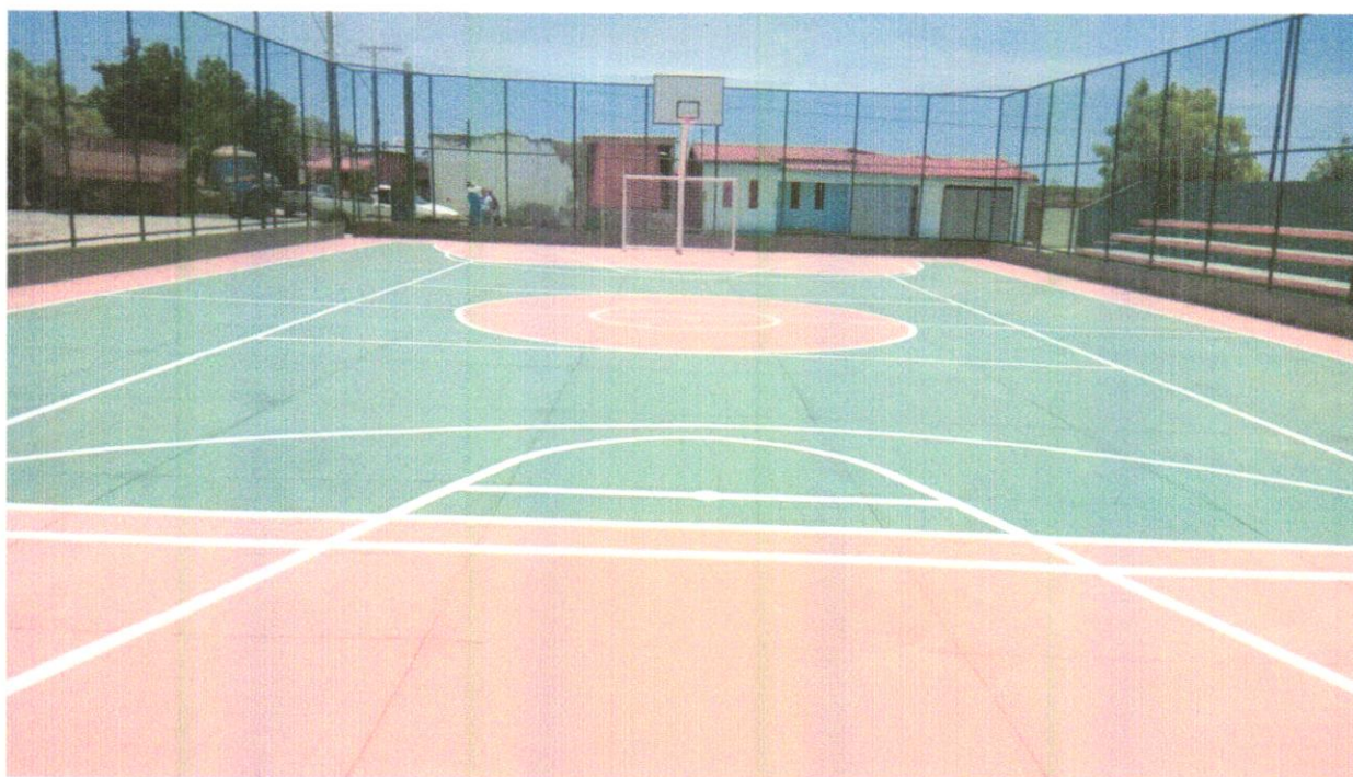
Foto 03 – Execução da tela de proteção e tabela de basquete.
