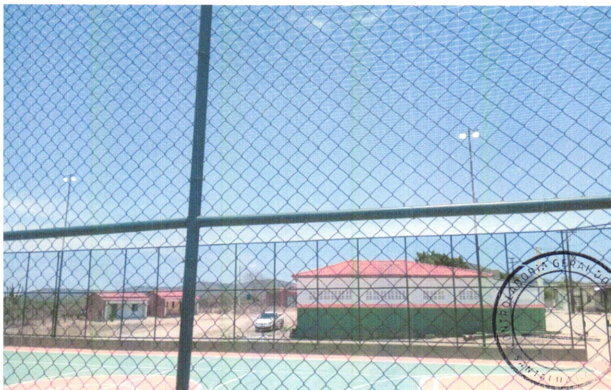
Foto 04 – Execução das luminárias.
