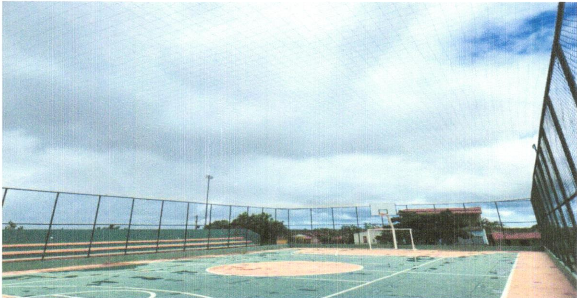
Foto 01 – Execução da tela de proteção e tabela de basquete.
