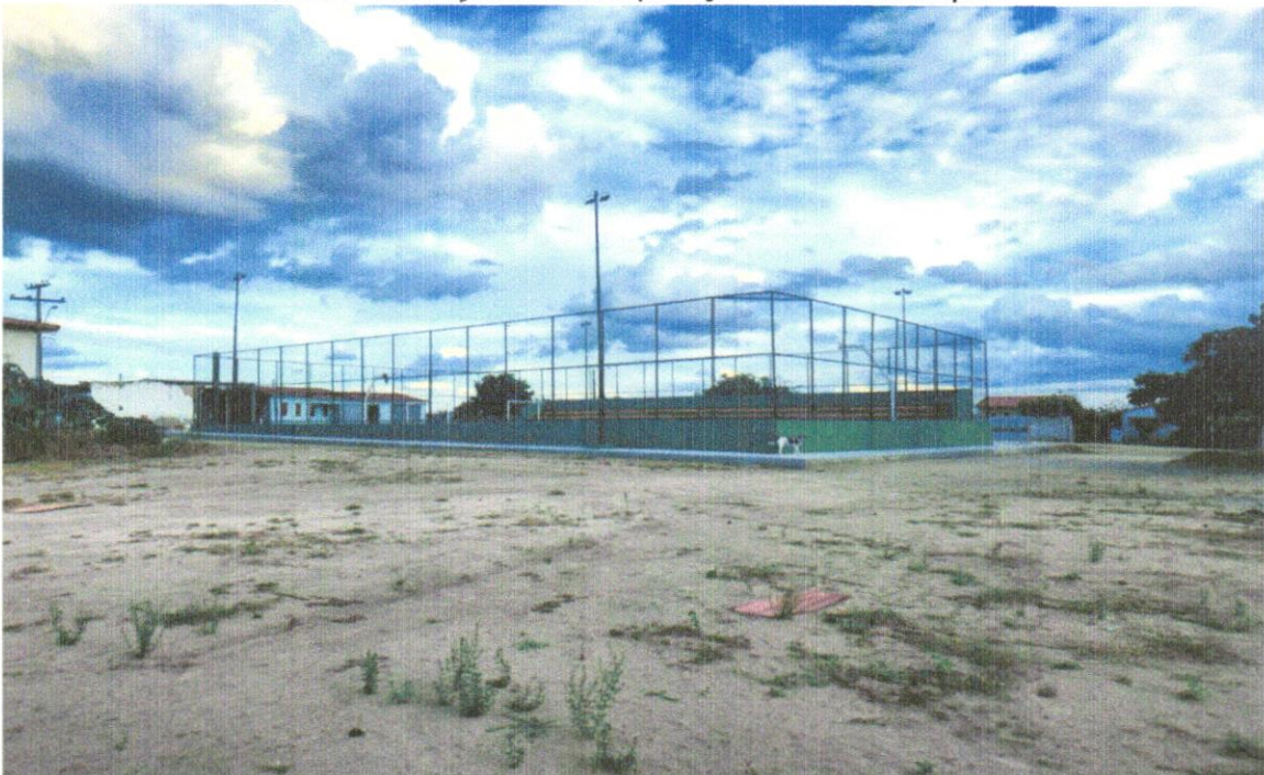
Foto 02 – Execução das luminárias.
