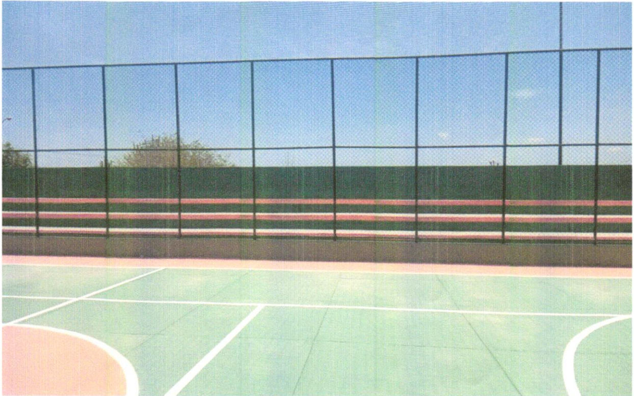
Foto 5: EXECUÇÃO DA REDE DE PROTEÇÃO
